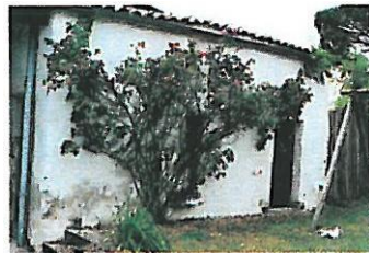
Un rosier habille' cette façade très simple.
