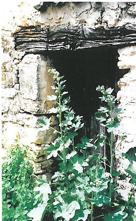
Tous les matériaux étaient tirés du sol environnant : terre cuite des tuiles, moellons de calcaire liés au mortier de chaux et sable, bois des forêts saintongeaises. La végétation locale, ici une rose trémière, habille et égale les abords.
